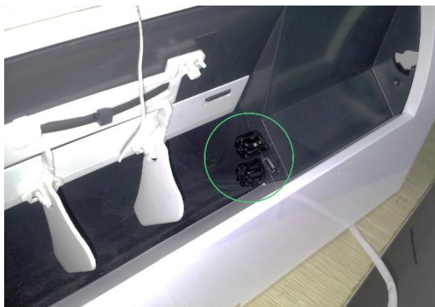
Фото 2. Встроенный ионизатор воздуха под передней панелью внутреннего блока сплит-системы.
